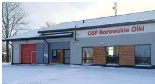
Świetlica wiejska w Borowskich Ciborach po rozbudowie.
