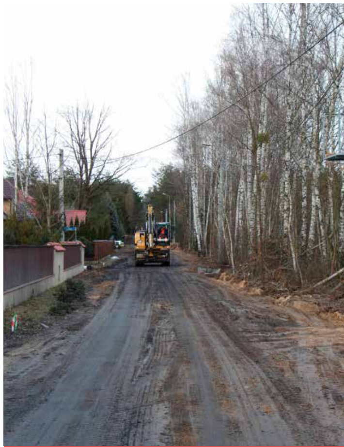
Trwa przebudowa ul. Polnej w Niewodnicy Kościelnej.
